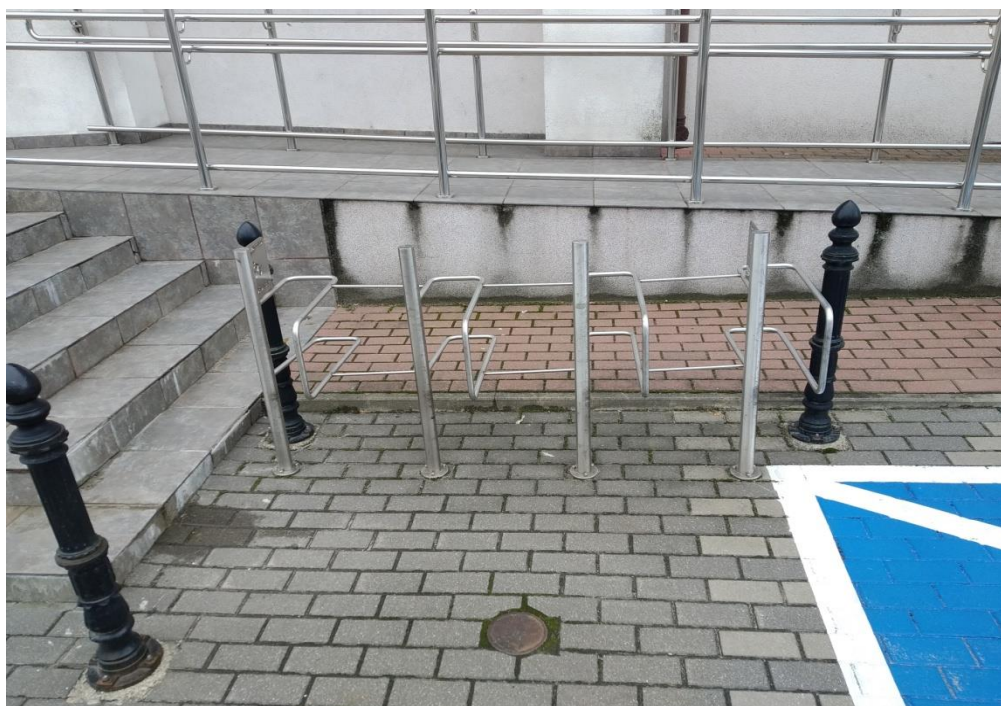
Przeniesienie stojaków na rowery z drugiej strony wejścia do Urzędu Miasta
